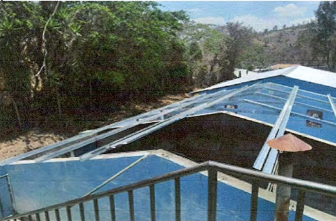
Foto 3: Área donde se esta colocando costaneras del aula
